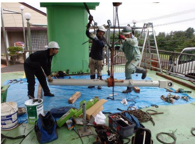
油圧緊張ユニット更新 油圧緊張シリンダー更新作業 メーカーおよび協力会社整備
