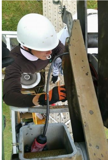
7号支柱受索装置(索輪)12輪更新自社整備
