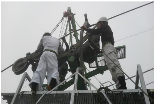
7号支柱受索装置(索輪)12輪更新自社整備
