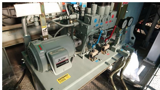
常用制動装置・ユニバーサルジョイント・制動装置油圧ユニット更新
