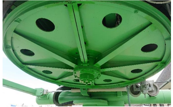
原動滑車軸オーバーホール ゴムライナー更新
