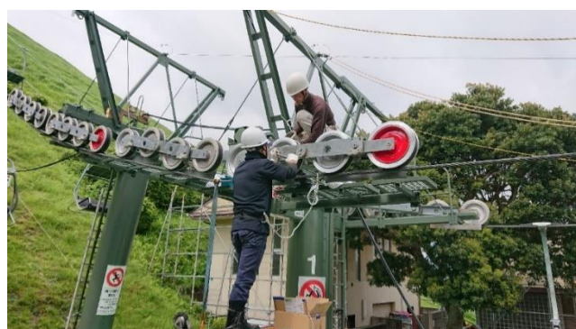
1号柱索輪交換作業
